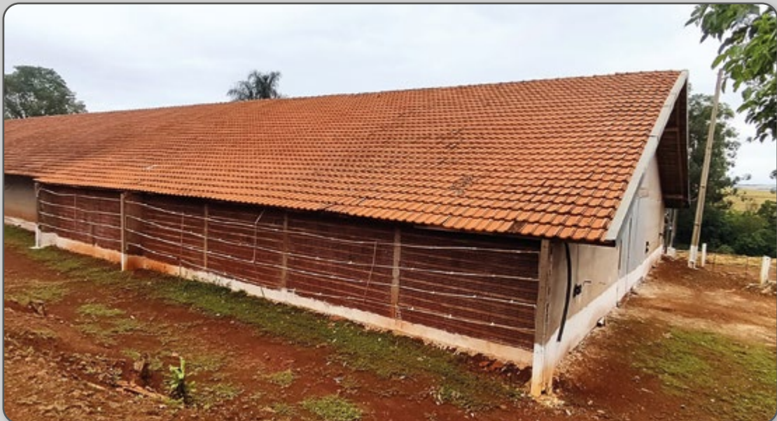
Figura 69 – Entrada de ar com tijolo vazado.
