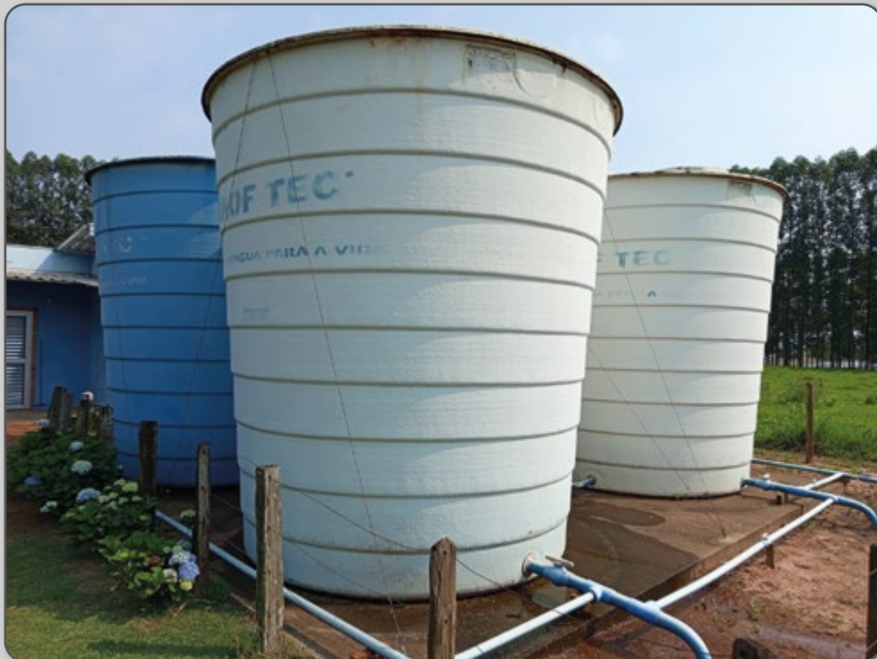
Figura 77 – Reservatório de água.
