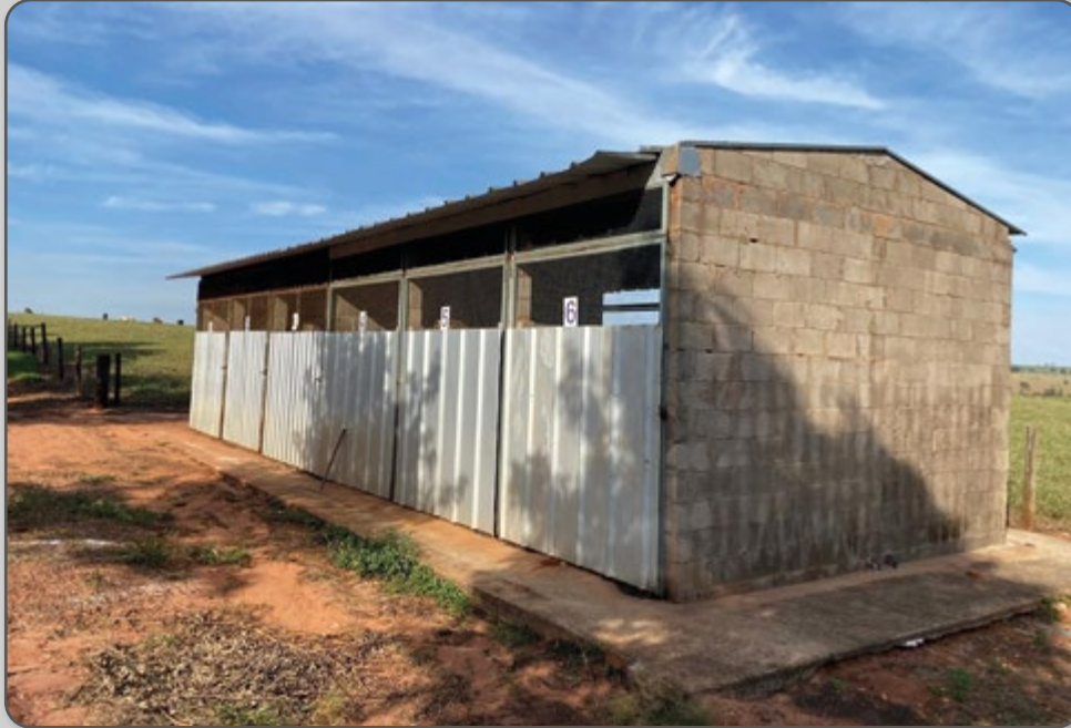
Figura 18 – Barracão de compostagem.
