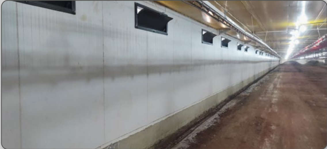
Figura 45 – Aviário com parede de isopainel.
