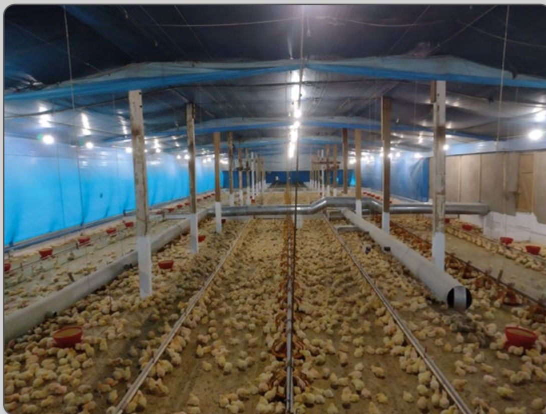
Figura 58 – Defletores amarrados próximo ao forro.
