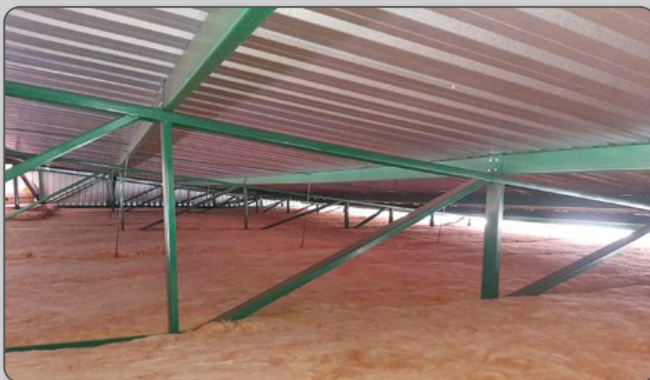
Figura 47 – Instalação de lã de vidro sobre a forração.
