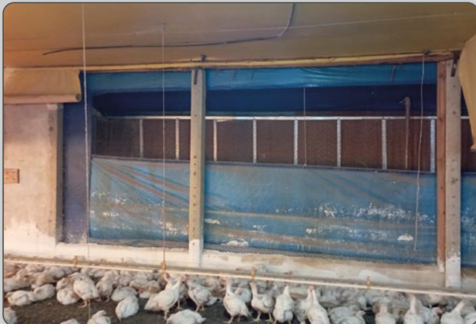
Figura 53 – Entrada de ar frontal controlada por cortina.
