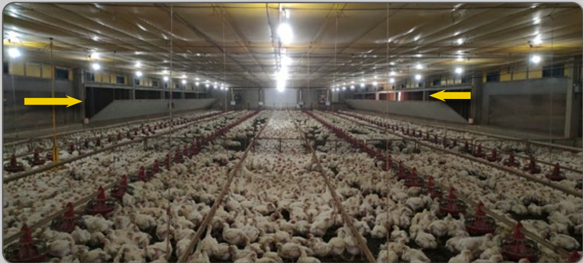
Figura 63 – Ventilação túnel. Inlets fechados, túnel door aberto.
