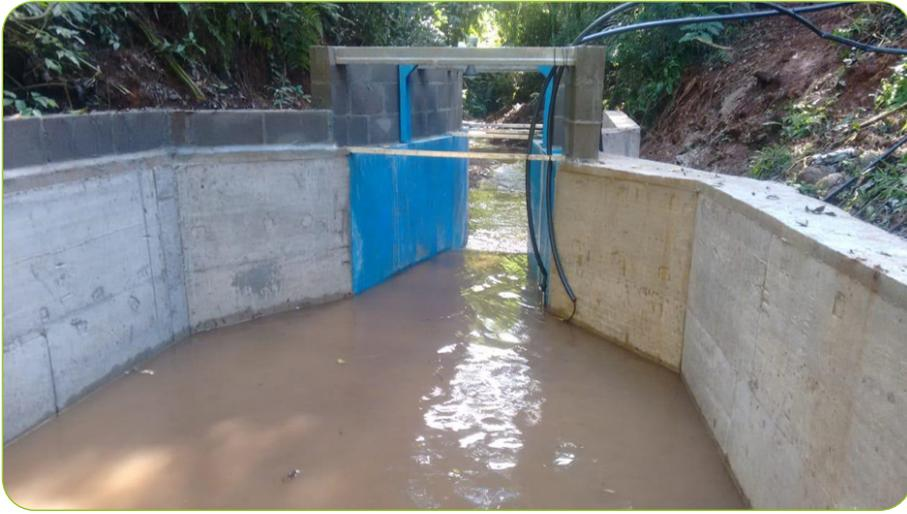
**Figura 7** – Calha Parshall instalada na bacia hidrográfica experimental de primeira ordem em Toledo-PR
