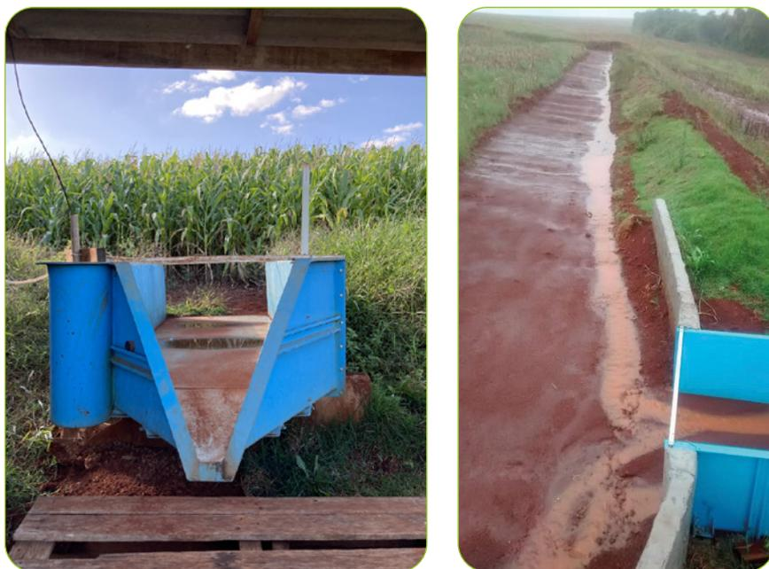
**Figura 12** – Calha H instalada no exutório das megaparcelas com e sem terraços, Cambé-PR
