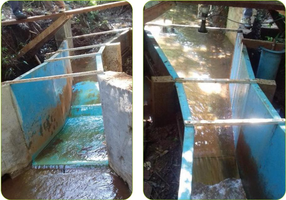
**Figura 9** – Calha Parshall instalada no rio de primeira ordem na bacia hidrográfica de Cambé-PR
