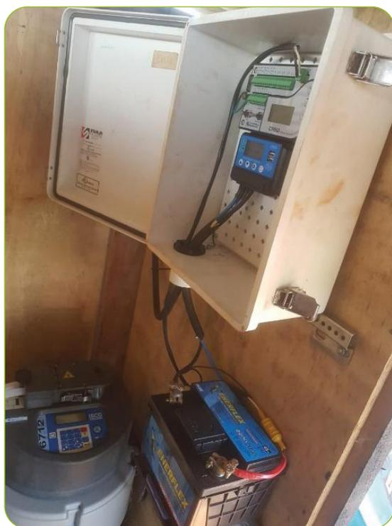
**Figura 10** – Amostrador automático de sedimento (ISCO®) instalado junto à calha Parshall no rio de primeira ordem de Cambé-PR
