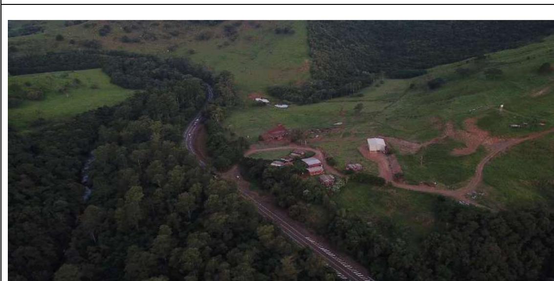
FOTOS 13 – 14- 15: Estruturas de Armazenagem – Estradas – Fundiárias em bom estado.
