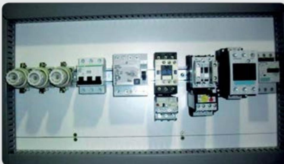
**Figura 103** – Dispositivos do circuito de controle.
