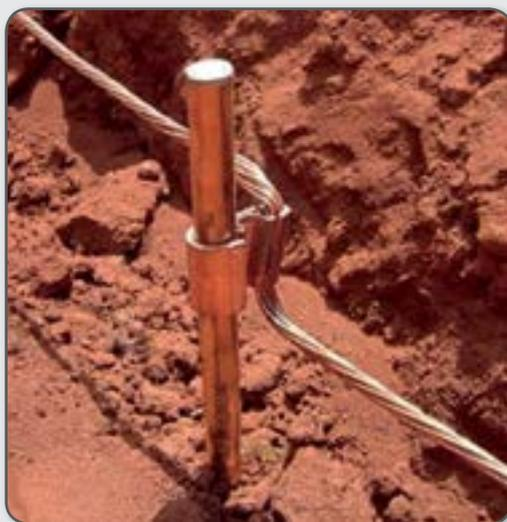
A conexão do cabo de cobre na haste de aterramento é feita através de abraçadeiras de bronze. A conexão mais eficaz é através da solda exotérmica.
